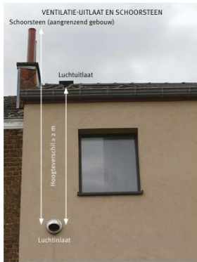
Afb. 24 Luchtinlaat die minstens 2 meter lager en op een andere gevel gelegen is dan de luchtuitlaat.
